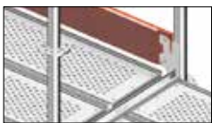
Montaje de rodapié de madera
