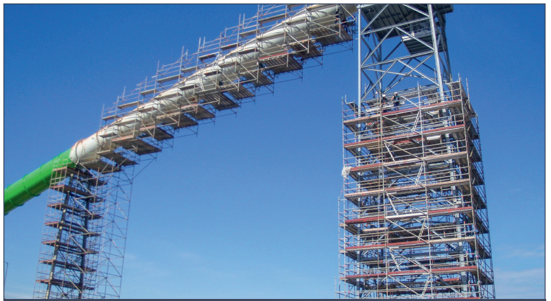
Estructura de andamios suspendidos que ahorra material
