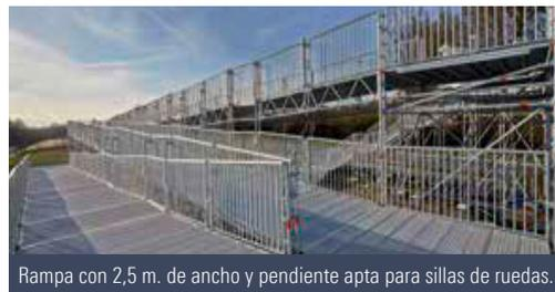
Rampa con 2,5 m. de ancho y pendiente apta para sillas de ruedas.
