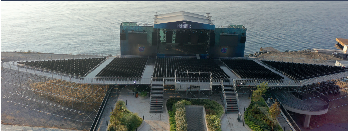
Escenarios y gradas montados con el sistema EV de Layher, teniendo como base estructuras de andamio multidireccional Allround.
