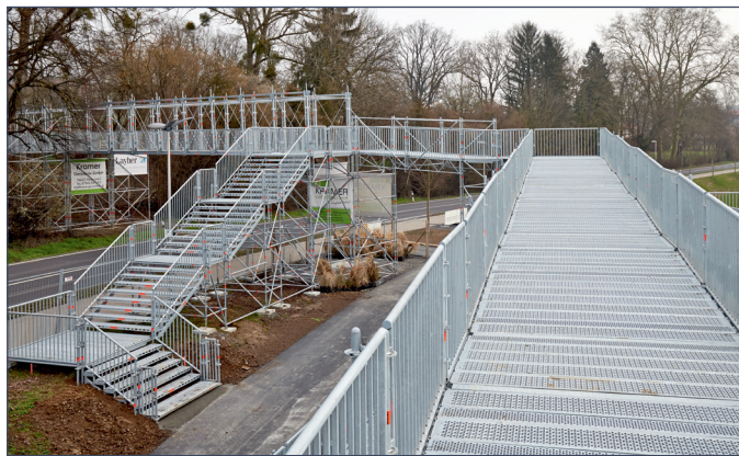
Pasarela peatonal temporal montada con componentes Allround.
