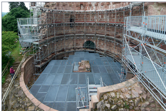
Soportes de iluminación y accesos montados con el sistema Allround.
