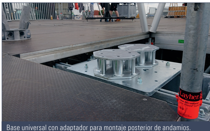
Uso de las bases en las esquinas del escenario para los soportes de cubierta.
