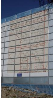
podemos cubrir tanto grandes alturas como grandes luces, dotando al edificio de una segunda piel que en ocasiones permanece como estructura fija. El sistema de paneles Protect emplea las modulaciones habituales de los sistemas de andamios, desde 0,73 a 3,07 m.
