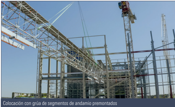
Colocación con grúa de segmentos de andamio premontados
