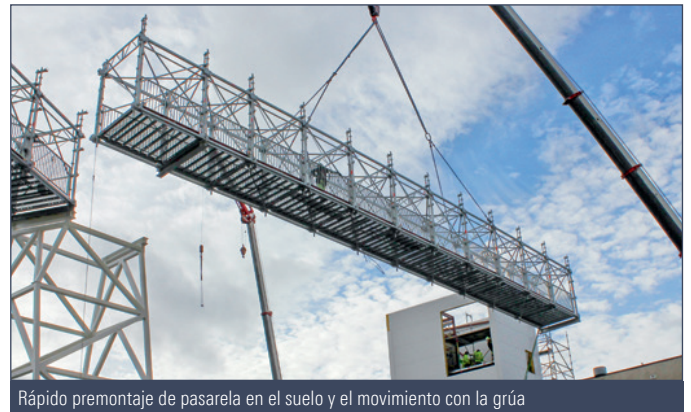
El movimiento de unidades de andamio completas reduce los tiempos de montaje
