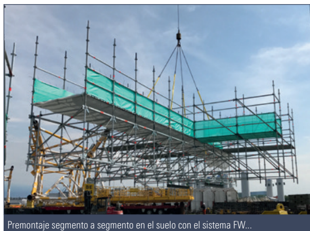
... y su posterior colocación in situ con una grúa.
