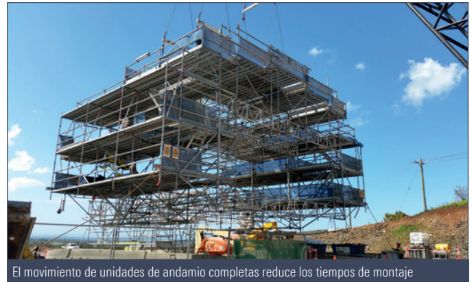
El movimiento de unidades de andamio completas reduce los tiempos de montaje
