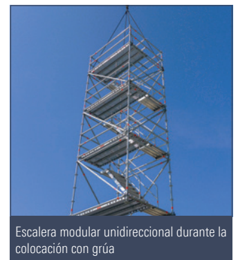
Rápido premontaje de pasarela en el suelo y el movimiento con la grúa
