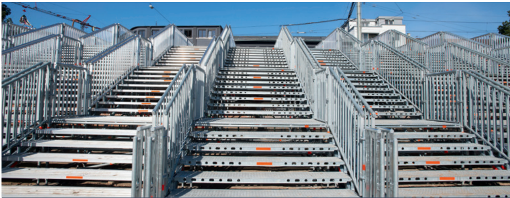
Escaleras de evacuación para un gran festival público con plataformas antideslizantes de acero y aluminio.
