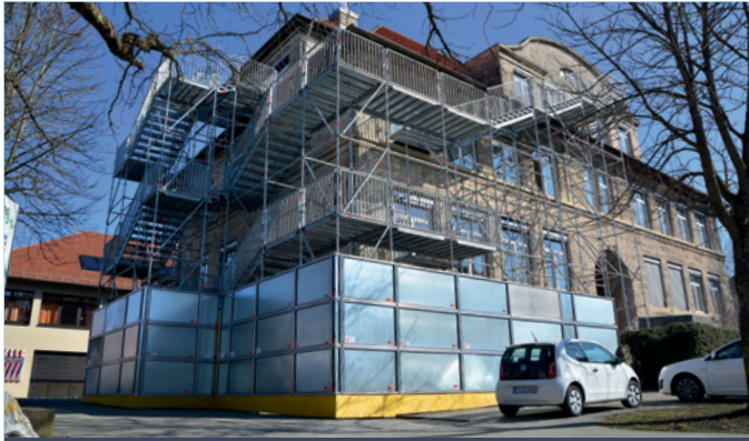
Escalera de evacuación temporal con cerramiento Protect, puerta y cerradura exterior para evitar accesos no autorizados.
