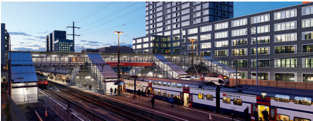
Pasarela provisional sobre las vías del tren en Altstetten.
