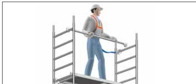
Fig. 3: colocación de las barandillas con EPI
