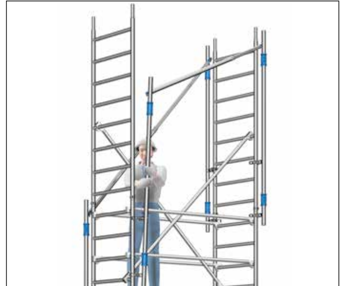
Fig. 5: Moviendo el AGS hacia arriba
